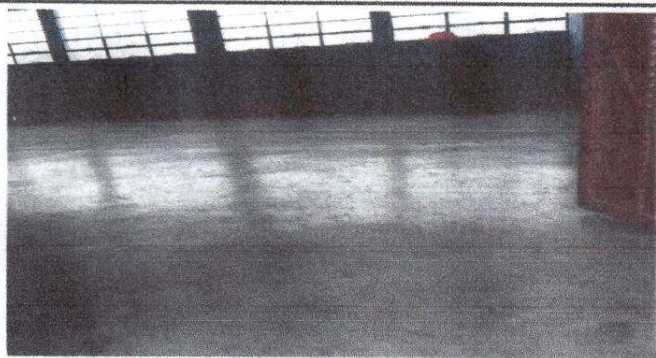
Foto 1: Sustitución de piso de cemento líquido (por ceramico)
