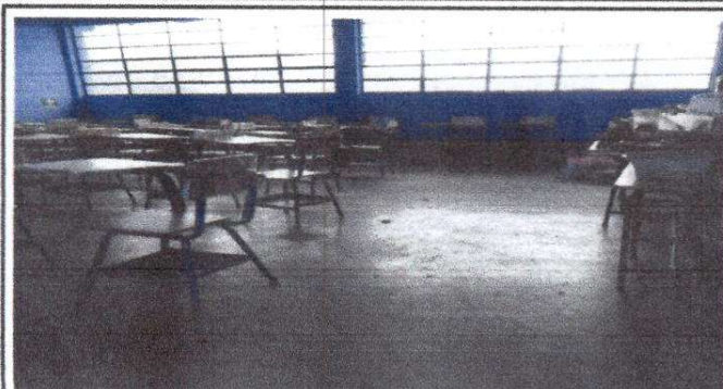
Foto 2: Sustitución de piso de cemento líquido (por ceramico)
